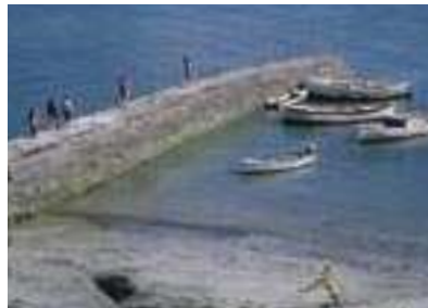
la jetée jetty
